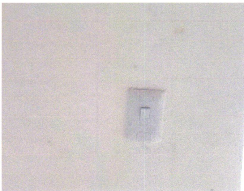
FOTO 09 - INTERRUPTOR SIMPLES (1 MÓDULO), 10A/250V, INCLUINDO SUPORTE E PLACA - FORNECIMENTO E INSTALAÇÃO. AF_12/2015
