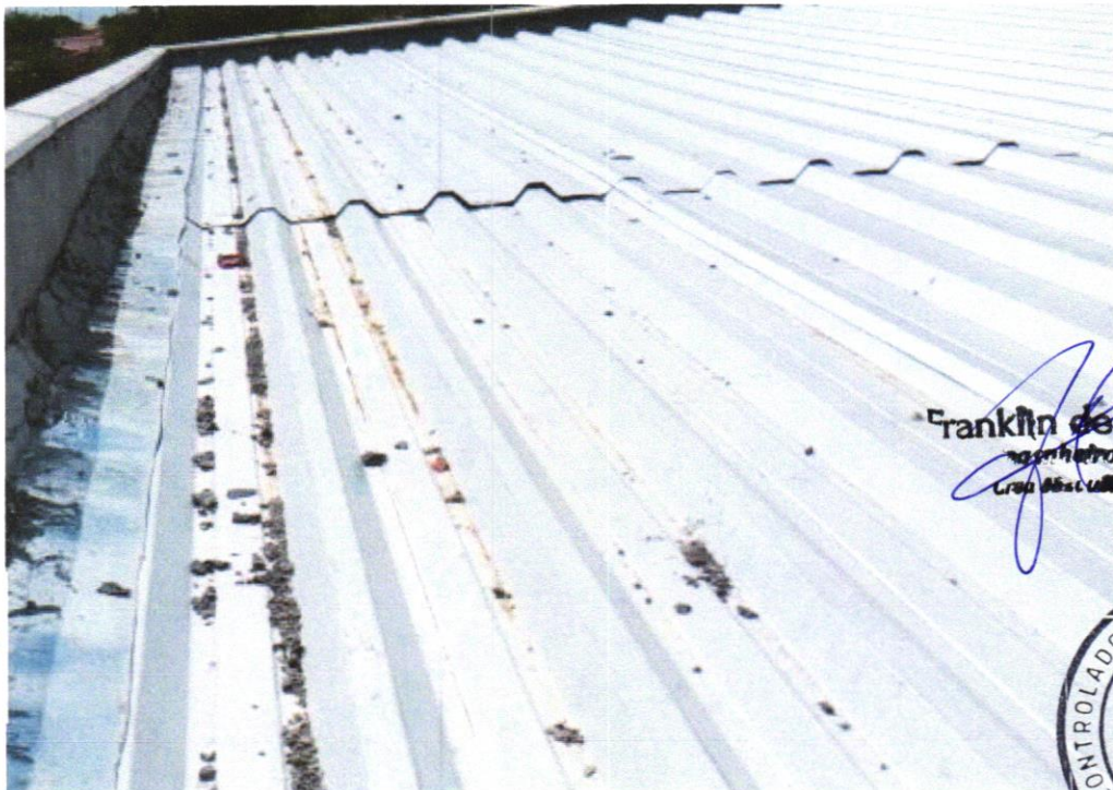
FOTO 06 – Rufo em chapa aço galvanizado nº24 com desenvolvimento 25cm
