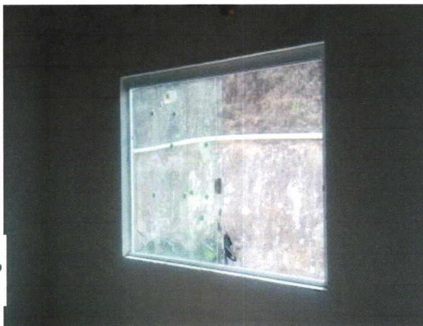
FOTO 27 - JANELA DE ALUMÍNIO DE CORRER COM 2 FOLHAS PARA VIDROS, COM VIDROS, BATENTE, ACABAMENTO COM ACETATO OU BRILHANTE E FERRAGENS. EXCLUSIVE ALIZAR E CONTRAMARCO. FORNECIMENTO E INSTALAÇÃO. AF_12/2019
