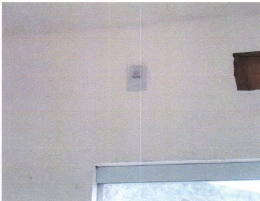
FOTO 11 - TOMADA ALTA DE EMBUTIR (1 MÓDULO), 2P+T 20 A, INCLUINDO SUPORTE E PLACA - FORNECIMENTO E INSTALAÇÃO. AF_12/2015
