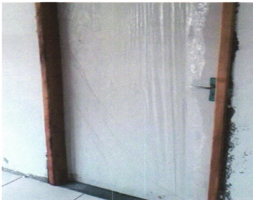
FOTO 25 - KIT DE PORTA-PRONTA DE MADEIRA EM ACABAMENTO MELAMÍNICO BRANCO, FOLHA LEVE OU MÉDIA, 90X210CM, EXCLUSIVE FECHADURA, FIXAÇÃO COM PREENCHIMENTO PARCIAL DE ESPUMA EXPANSIVA - FORNECIMENTO E INSTALAÇÃO. AF_12/2019
