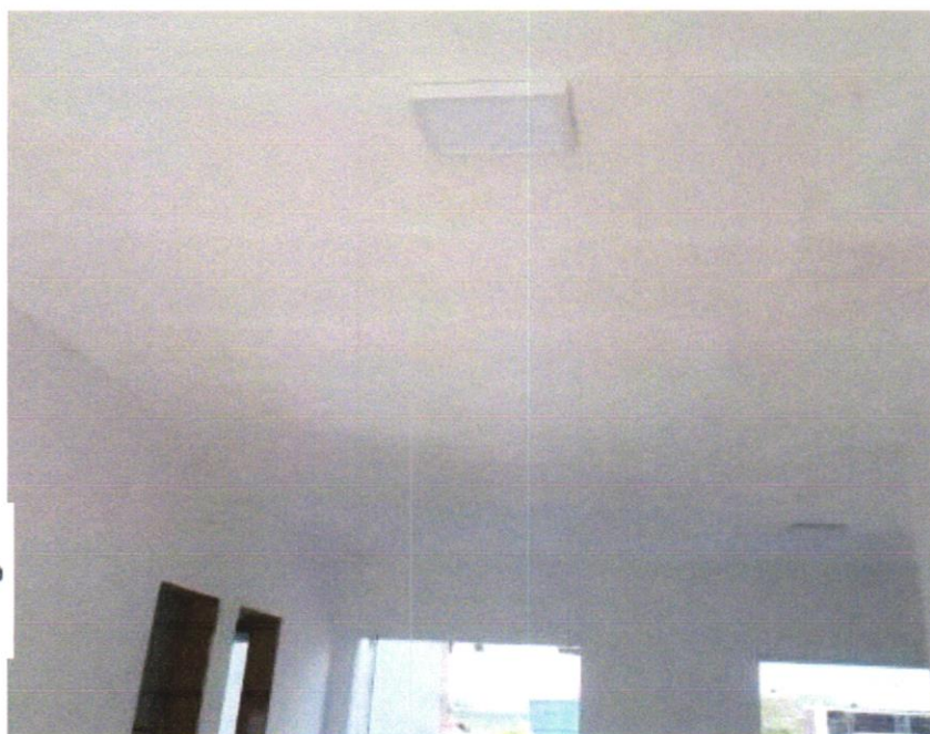
FOTO 13 - Luminária sobrepor quadrada Led 24W*, 6500K G- Light ou similar
