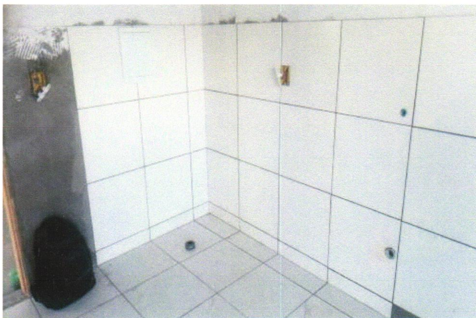
FOTO 23 - REVESTIMENTO CERÂMICO PARA PAREDES INTERNAS COM PLACAS TIPO ESMALTADA EXTRA DE DIMENSÕES 33X45 CM APLICADAS EM AMBIENTES DE ÁREA MAIOR QUE 5 M 2 A MEIA ALTURA DAS PAREDES. AF_06/2014
