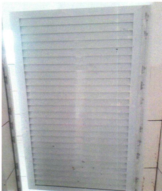
FOTO 32 - PORTA EM ALUMÍNIO DE ABRIR TIPO VENEZIANA COM GUARNIÇÃO, FIXAÇÃO COM PARAFUSOS - FORNECIMENTO E INSTALAÇÃO. AF_12/2019
