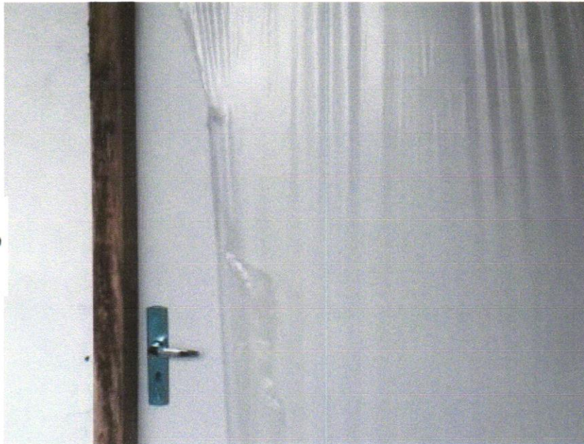
FOTO 19 - FECHADURA DE EMBUTIR PARA PORTAS INTERNAS, COMPLETA, ACABAMENTO PADRÃO MÉDIO, COM EXECUÇÃO DE FURO - FORNECIMENTO E INSTALAÇÃO. AF_12/2019
