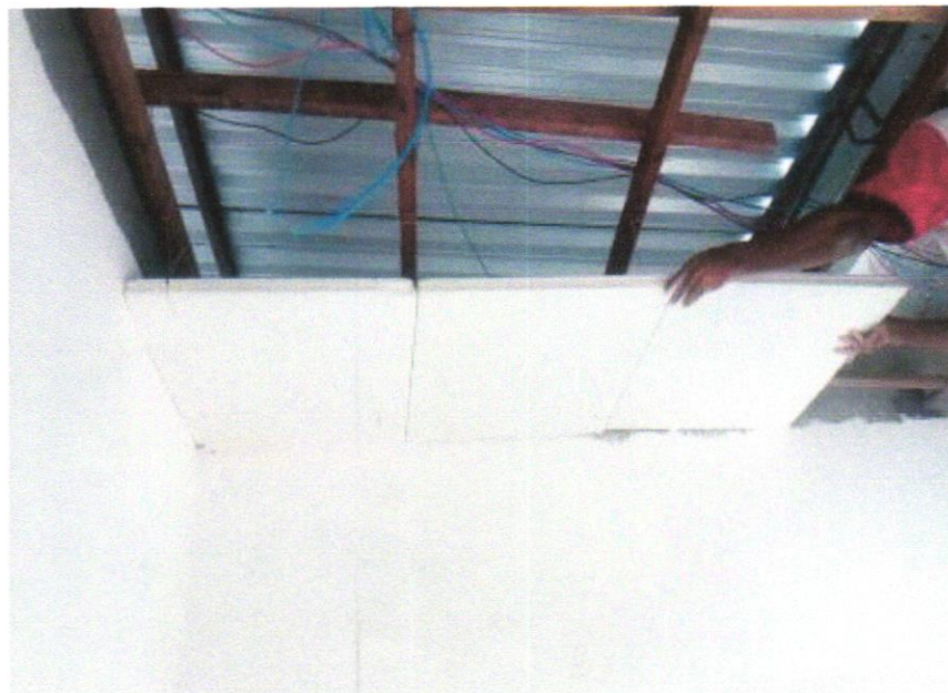
FOTO 04 - Forro de gesso comum, em placas 60x60 cm, inclusive madeiramento com ripões 3,5cm x 5,5cm, instalado
