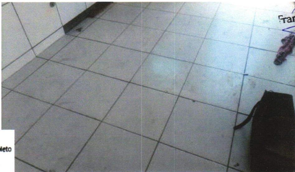
FOTO 22 - REVESTIMENTO CERÂMICO PARA PISO COM PLACAS TIPO ESMALTADA EXTRA DE DIMENSÕES 45X45 CM APLICADA EM AMBIENTES DE ÁREA ENTRE 5 M2 E 10 M2. AF_06/2014
