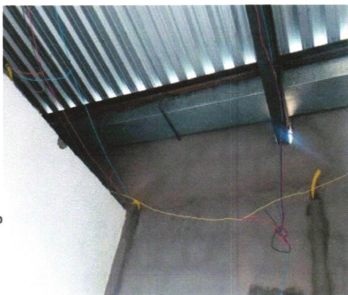
FOTO 02 – CALHA EM CHAPA DE AÇO GALVANIZADO NÚMERO 24, DESENVOLVIMENTO DE 100 CM, INCLUSO TRANSPORTE VERTICAL. AF_07/2019
