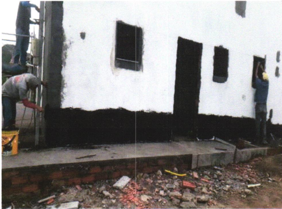
FOTO 21 - IMPERMEABILIZAÇÃO DE SUPERFÍCIE COM MANTA ASFÁLTICA, UMA CAMADA, INCLUSIVE APLICAÇÃO DE PRIMER ASFÁLTICO, E=3MM. AF_06/2018
