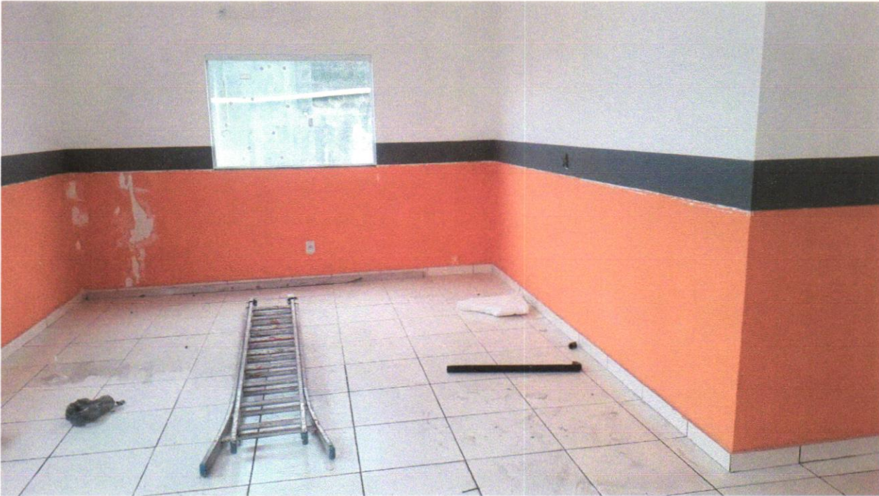
FOTO 31 - APLICAÇÃO MANUAL DE PINTURA COM TINTA LÁTEX ACRÍLICA EM PAREDES, DUAS DEMÃOS. AF_06/2014
