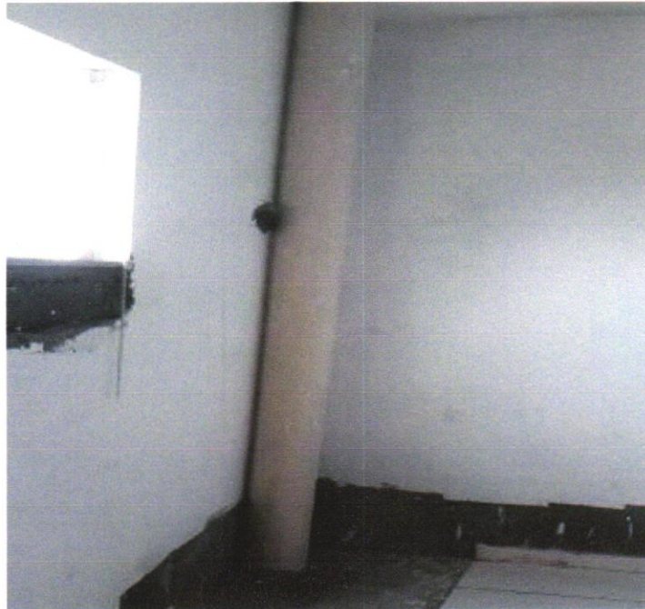
FOTO 03 - TUBO PVC, SÉRIE R, ÁGUA PLUVIAL, DN 100 MM, FORNECIDO E INSTALADO EM RAMAL DE ENCAMINHAMENTO. AF_06/2022
